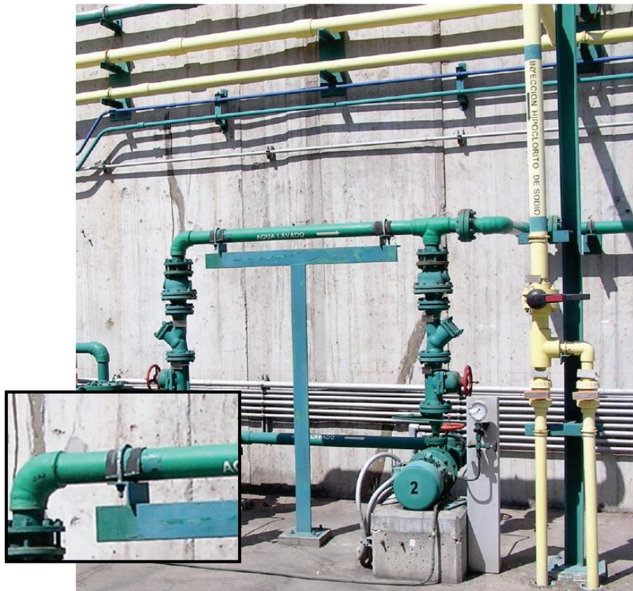
איור 6.4.3.5-1 – הזזות אופקיות של צינור עם תמיכה, ניתן לראות שבורג U לא סיפק קיבוע למרות הוספת פד להגברת מקדם החיכוך בין הצינור לבורג.
