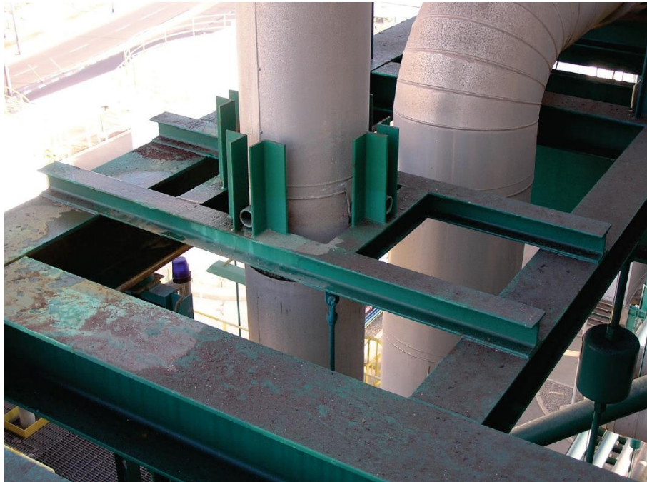
איור 6.4.3.4-4 – צינור אנכי מעוגן אופקית ע"י חתך צינור עגול בתוך מסילה אנכית.
