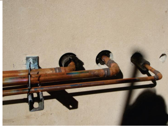
איור 3-6.4.3.7 – דוגמא לתמיכות וחיבורים טיפוסיים לעיגון צנרת בקיר. בתמונה התחתונה הרכבת העיגון נמצאת בתהליך והצנרת מחוברת לקיר בחיבורי פלסטיק באופן זמני.
