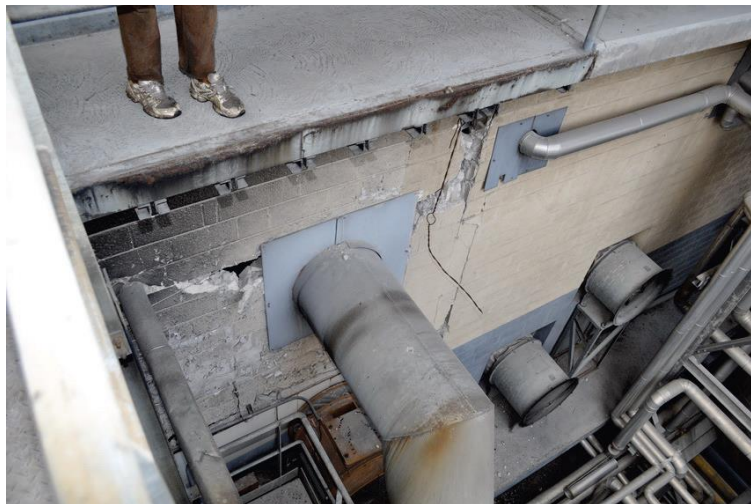
איור 3-6.4.3.8 – צנרת ותעלות חודרות קיר גרמו לפגיעה בקירות בלוקים לא מזויינים במפעל תעשייתי. הצנרת והתעלות לא נפגעו, אך הקיר ניזוק ונדרש לעבור תיקון.
