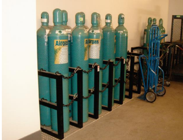
איור 6.4.2.3-7 – החזקת בלוני גז בבית חולים, אבטוח באמצעות שרשרת המאפשרת גישה מהירה.
