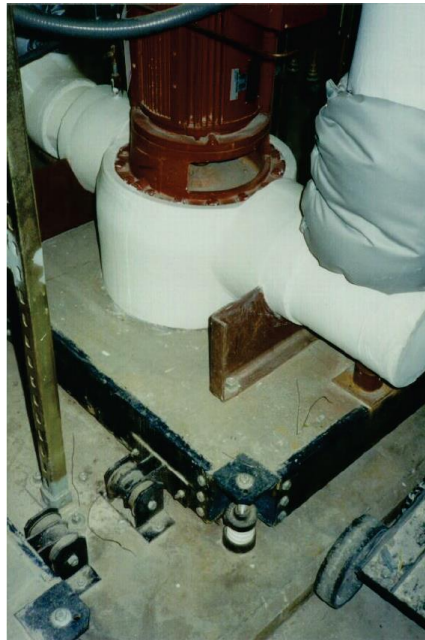
איור 6.4.3.2-1 – משאבה על צינור קו היושבת על משטח עם מבודד תנודות ומוקפת בסנאברים.
