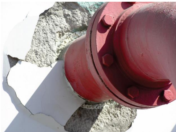
איור 2-6.4.3.8 – נזק שנגרם לטיח סטוקו חיצוני באזור חדירת צנרת כיבוי אש.
